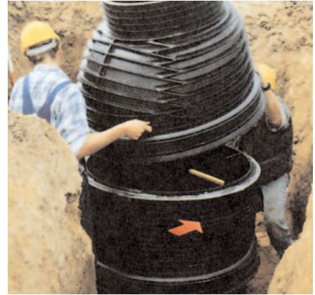
6. Schachtkonus entsprechend dem Steiggang im Schachtrohr ausrichten und bis zum Anschlag aufschieben (nicht verkanten).
