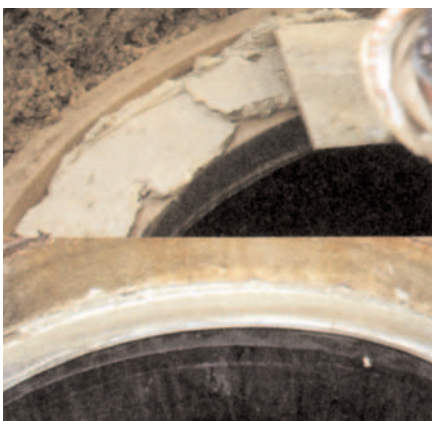
10. Die Begu-Abdeckung ist auf dem Betonring mit dem Ausgleichsmörtel, z.B. Estrichmörtel, gemäß DIN 4034 zu setzen. Während der Bauphase Schacht mit Stahlabdeckplatte o.ä. abdecken. Punktlasten zwischen Abdeckung, Betonauflagering sowie Auflager vermeiden.
