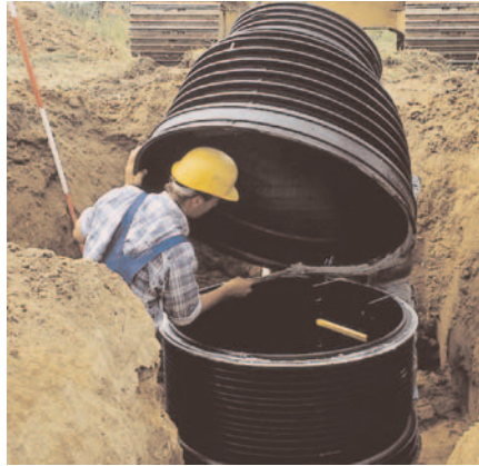
5. ... in der Muffe des Schachtkonus auftragen.
