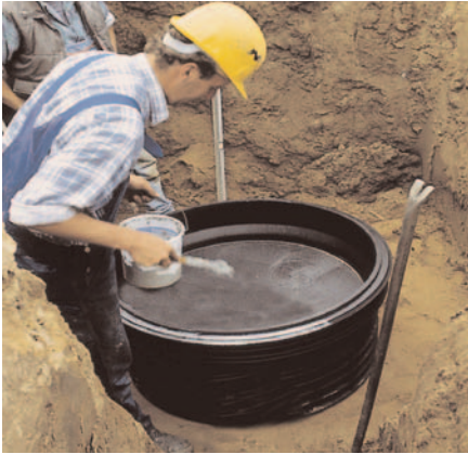
4. Gleitmittel gleichmäßig auf das Dichtelement am Schachtrohr und ...
